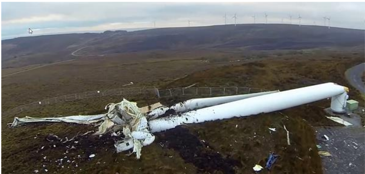
Abbildung 1.2: Strukturschaden einer Windenergieanlage am 03.01.2015 in Nordirland 3
