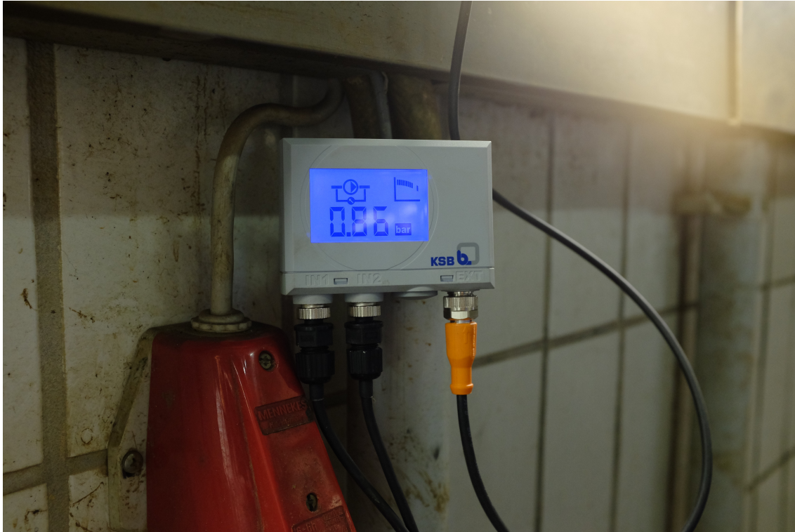
Abb. E Montage des PumpMeter Moduls zur Pumpendiagnose.
