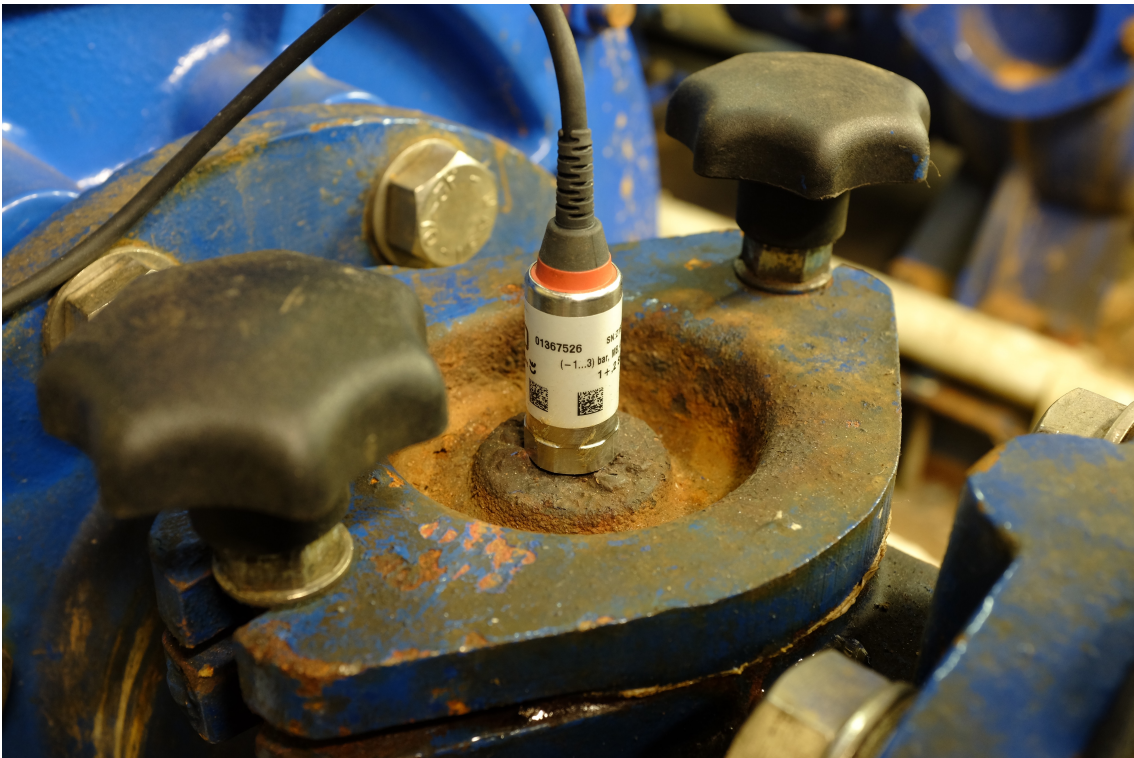
Abb. D Montage des saugseitig montierten Sensors im Wartungsdeckel.
