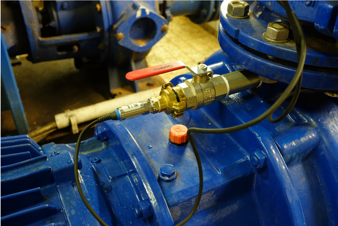
Abb. C Montage des druckseitig montierten Sensors am Kugelhahn.
