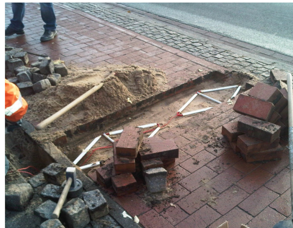
(b) Zwei Induktionsschleifen in der Installationsphase
