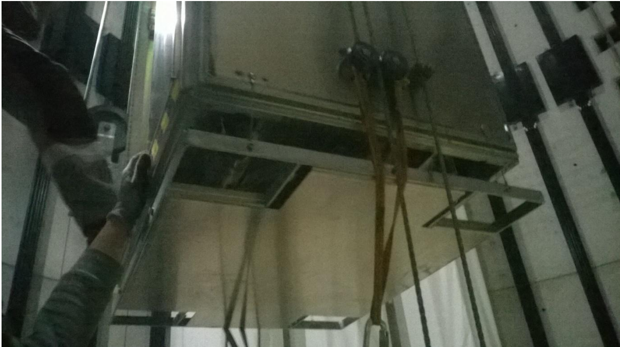
Abbildung 1: Anbringung der Haltegurte an der Seilführung
