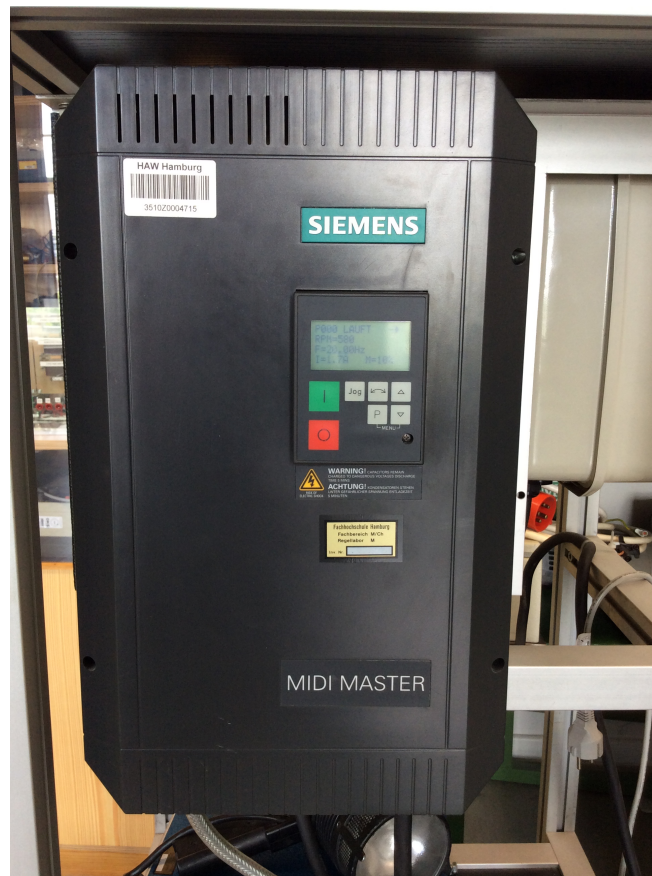
Abbildung 2.8.: Frequenzumrichter der Marke Siemens
