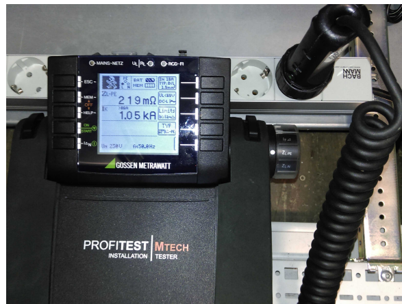
Abbildung 5.5.: Prüfung der Steckdosen mit Profitest MTech
