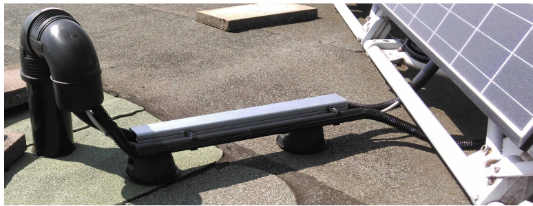
Abbildung 5.2.: Kabeleinführung vom Dach in den Raum 15.80
