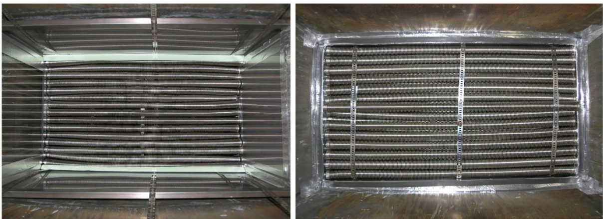
Abbildung 3.5: Positionierung der Stacks im Speichertank (horizontal)
