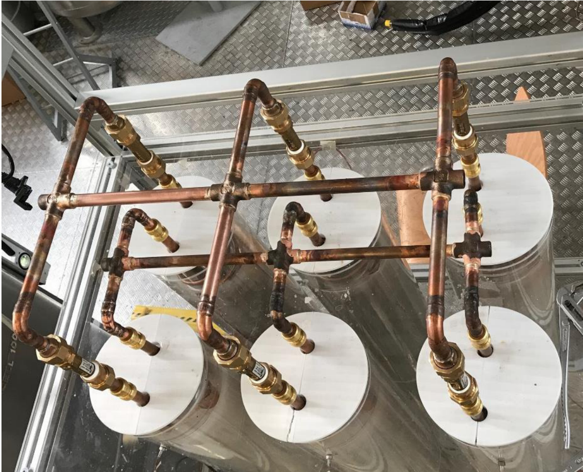
Abbildung 22: Rohrkonstruktion zur Be- und Entladung
