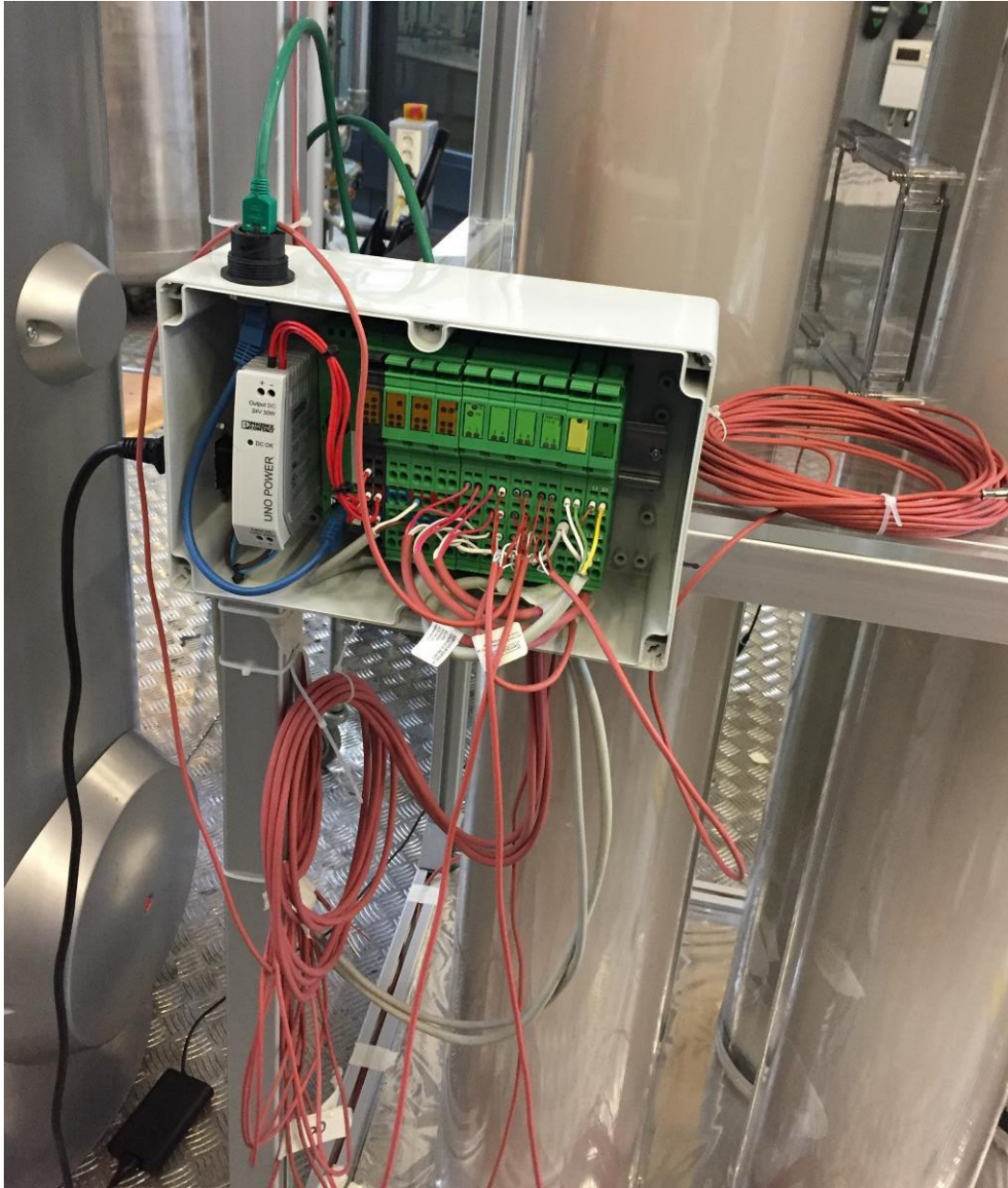
Abbildung 10: Istzustand Kabelverlegung
