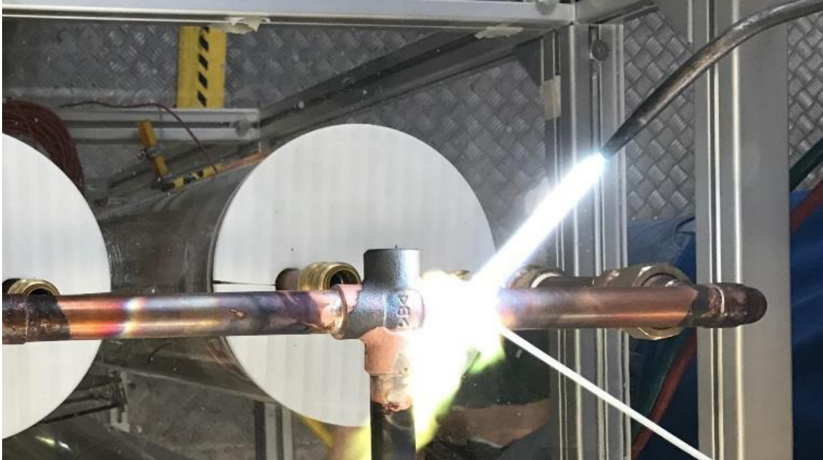
Abbildung 21: Löten der Rohrverbindungen
