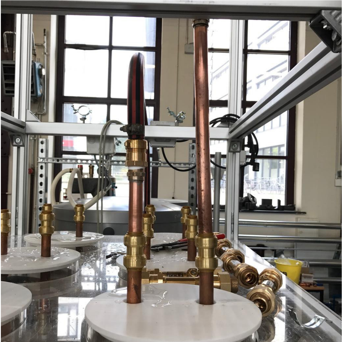
Abbildung 20: Spülen der Speicher
