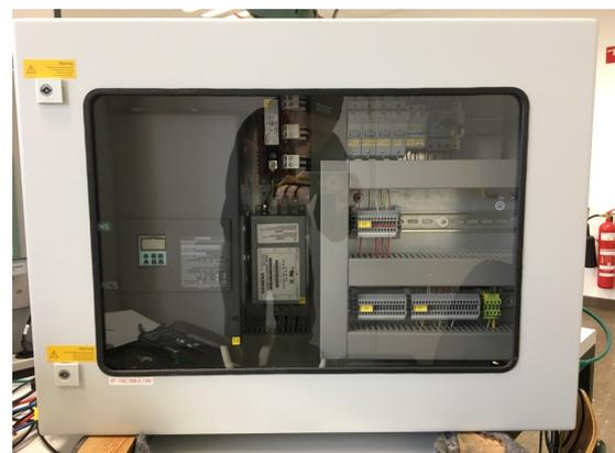
Abbildung 2.12: Stromrichter Schaltschrank
