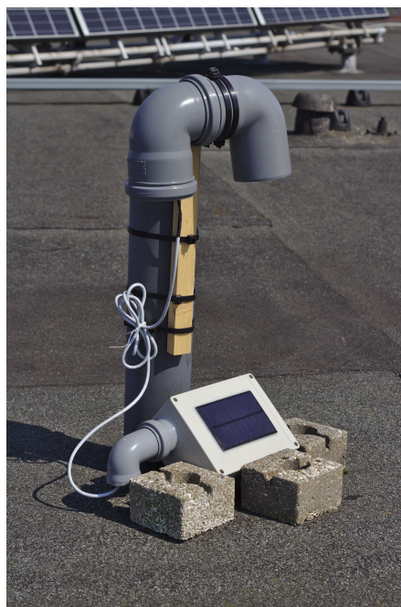
Abbildung 7.5.: Box-5 mit Rohrbogen zur Unterbringung des Feinstaubsenors
