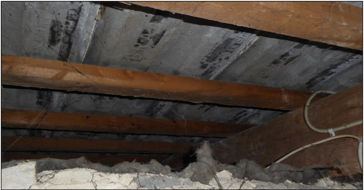
Abbildung 5.21: Ungedämmtes Dach der Unterkunft
