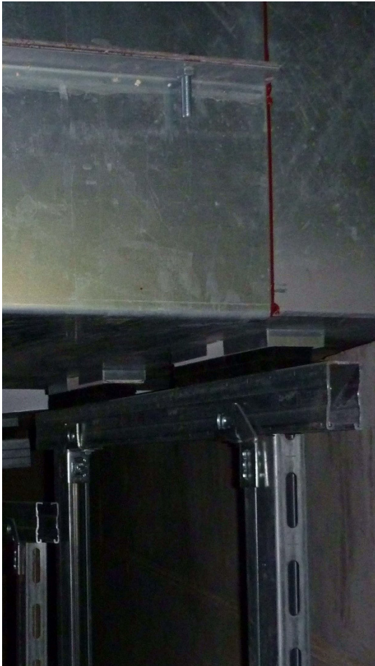
Abb. 29 Aufnahme der montierten Halterungskonstruktion vor Ort
