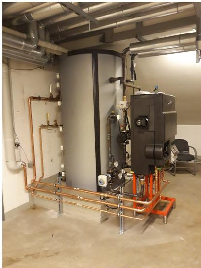
Abbildung 2.6.: Wärmespeicher und WÜST der realen iWÜST [15]
