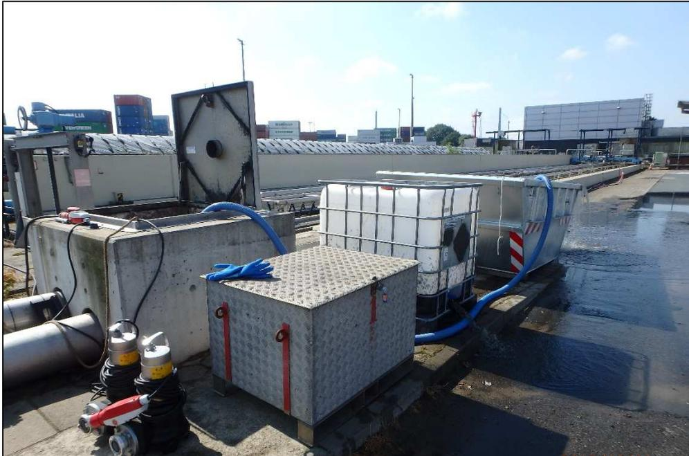
Abbildung 11: Entnahme des Sandfangguts aus dem Sandfanggut-Schacht
