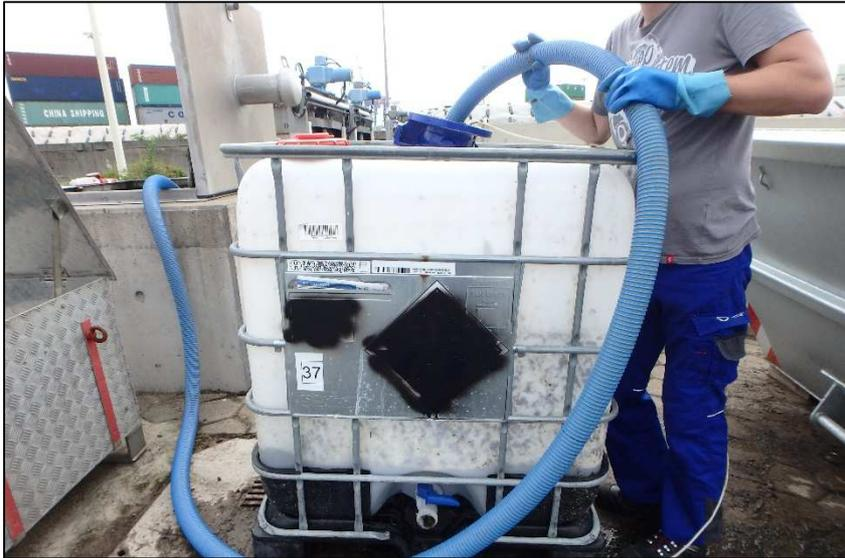
Abbildung 18: Auslitern der Förderleistung der Pumpe im Sandfanggut-Schacht
