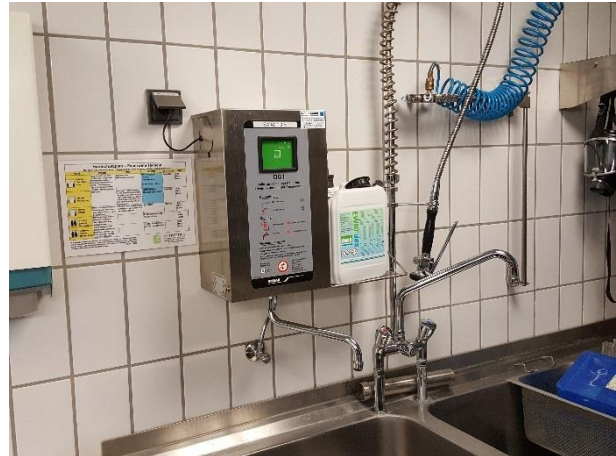
Abbildung 16: Desinfektionsstation für die Atemschutzmasken Quelle: eigene Darstellung)
