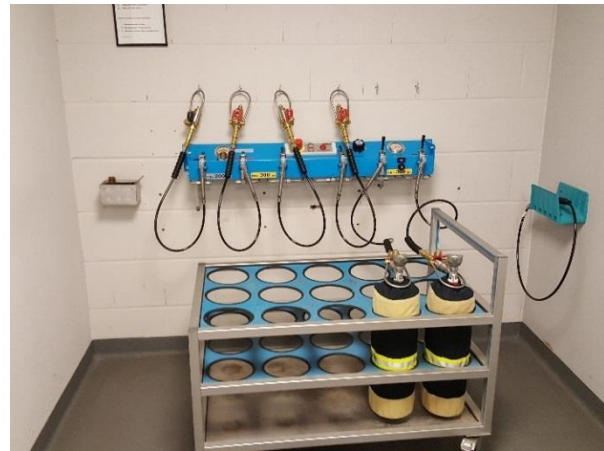
Abbildung 28: Füllvorgang der Druckluftflaschen (Quelle: eigene Darstellung)
