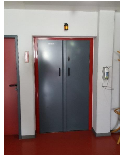
Abbildung 26: Blick auf die geschlossene Zugangstür (Quelle: eigene Darstellung)
