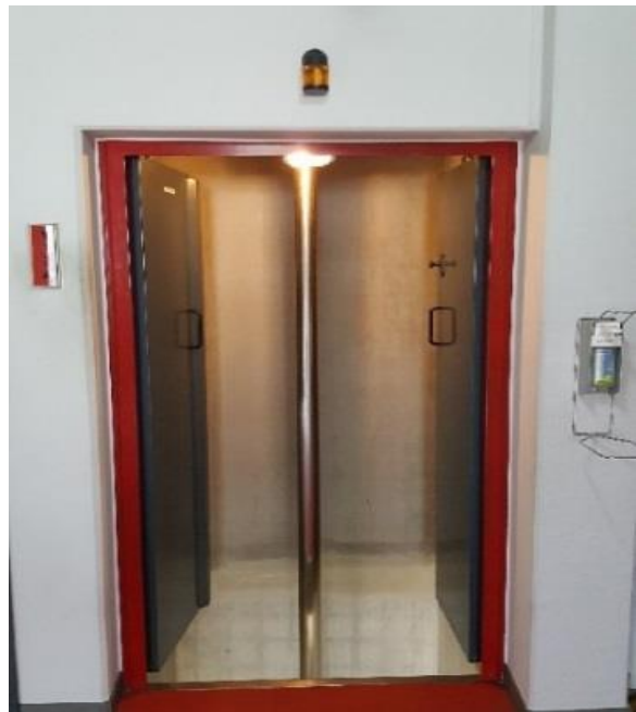
Abbildung 15: Zugangstür zur Rutschstange (Quelle: eigene Darstellung)
