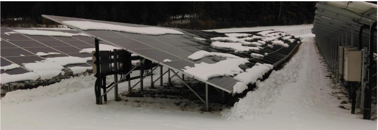
**Bild 5.3** Liegen bleibender Schnee auf konventionell ausgerichteten Modulen (Enerparc 2017)
