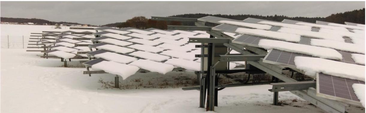
**Bild 5.4** Liegen bleibender Schnee bei X-Modul-Montage (Enerparc 2017)
