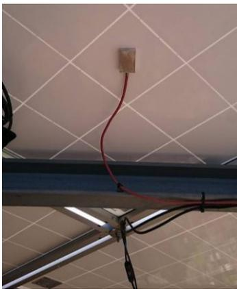
**Bild 2.5** Sensor für die Modultemperatur
