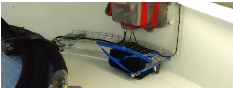
Abbildung 6-2: Für die Aufrichtung befestigter Messkoffer (RECASE - Regenerative Energien GmbH, 2017, p. 6)
