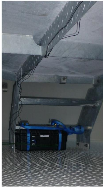
Abbildung 5-9: Kabelanbringung
