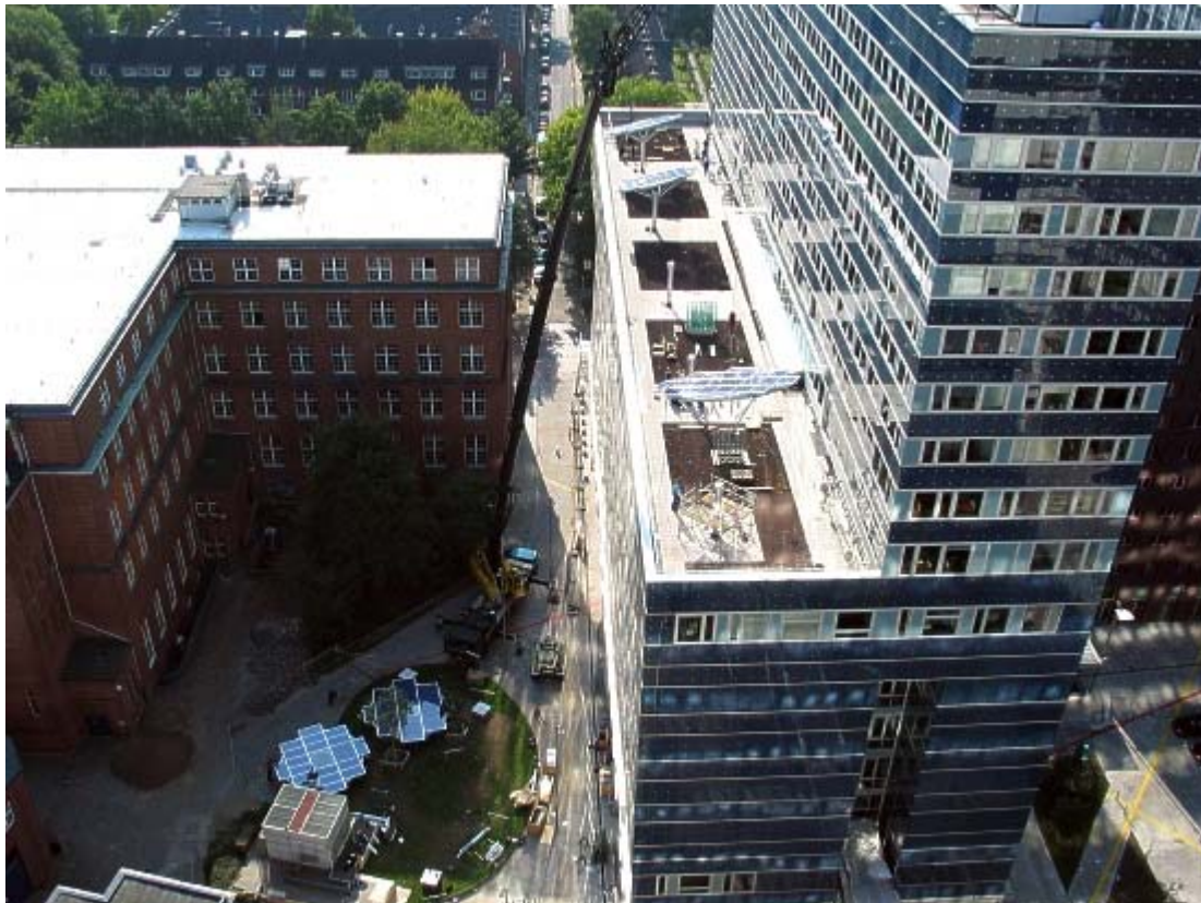
Abbildung 2: Montage der Solaranlage auf dem Neubau der HAW-Hamburg [6]
