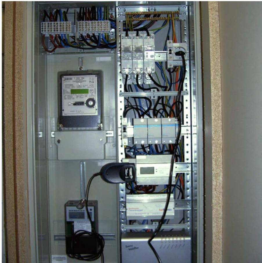
Abbildung 19: Aufbau Solarschaltsschrank
