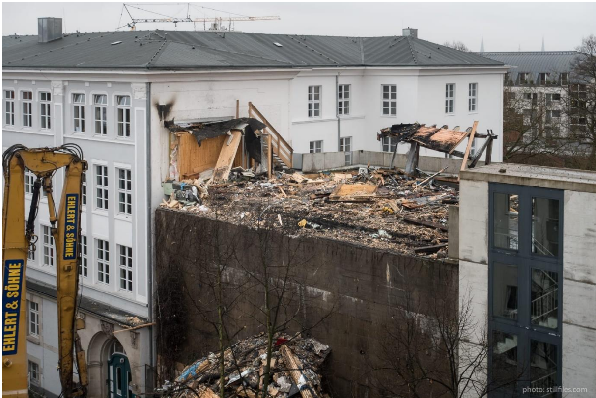
Abbildung 4 Abtragung der Holzkonstruktion (Foto: D. Manduzio, http://stillfiles.com , Nutzung mit freundlicher Genehmigung)
