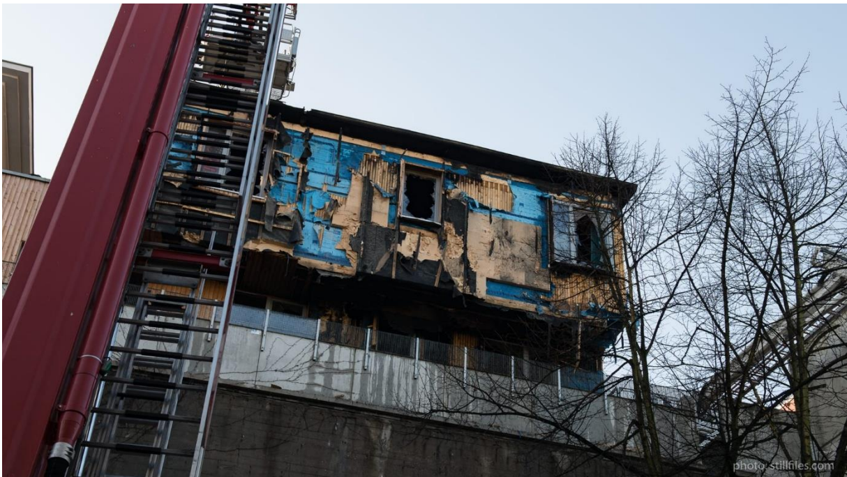
Abbildung 3 Brand in einer Holzkonstruktion (Foto: D. Manduzio, http://stillfiles.com , Nutzung mit freundlicher Genehmigung)
