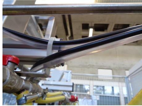
Abbildung 17: Schwarze Färbung der Nährstoffzulaufschläuche durch die Spurenelemente (eigene Darstellung)
