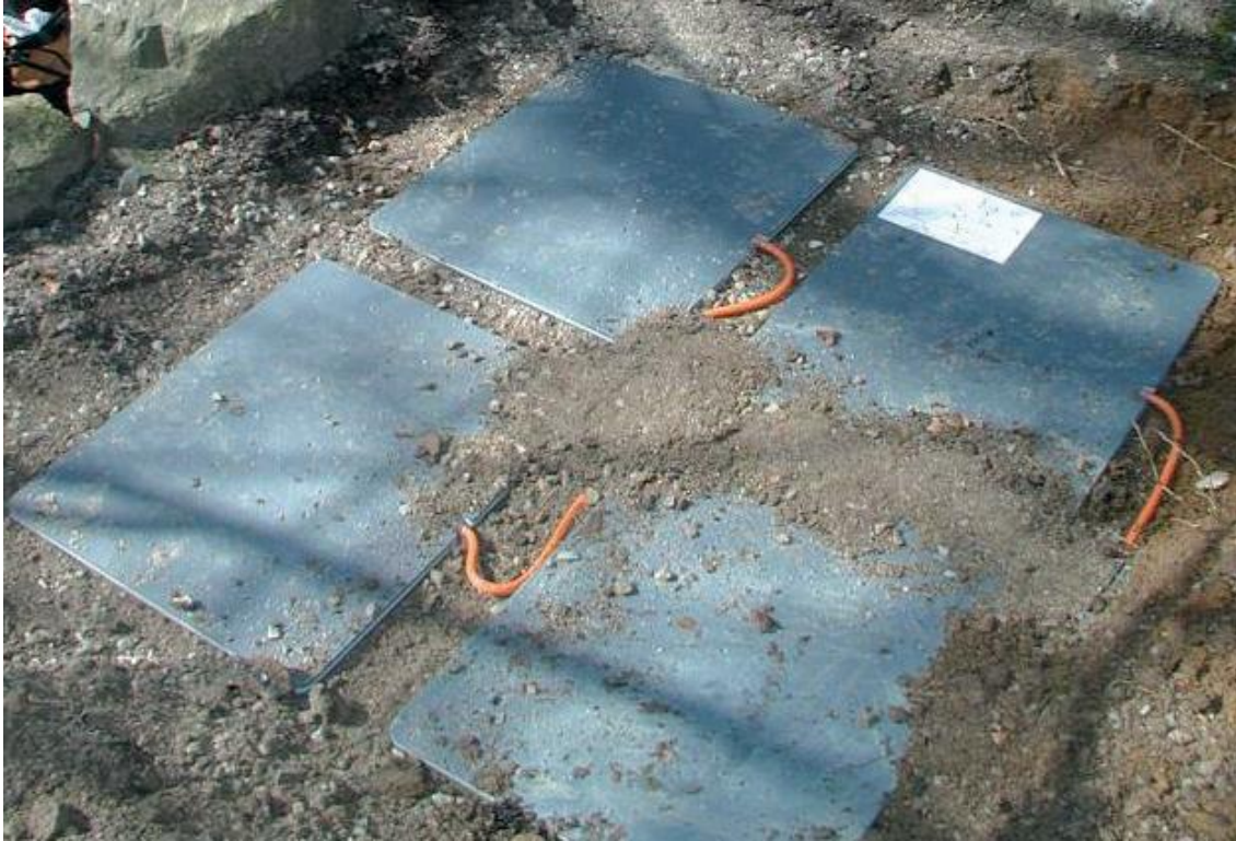
Abbildung 11 Verlegung eines Plattensensor der Firma EcoCounter 43
