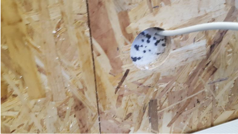
Abbildung 13: Kabelausführung durch die Rückseite der Klima-Box
