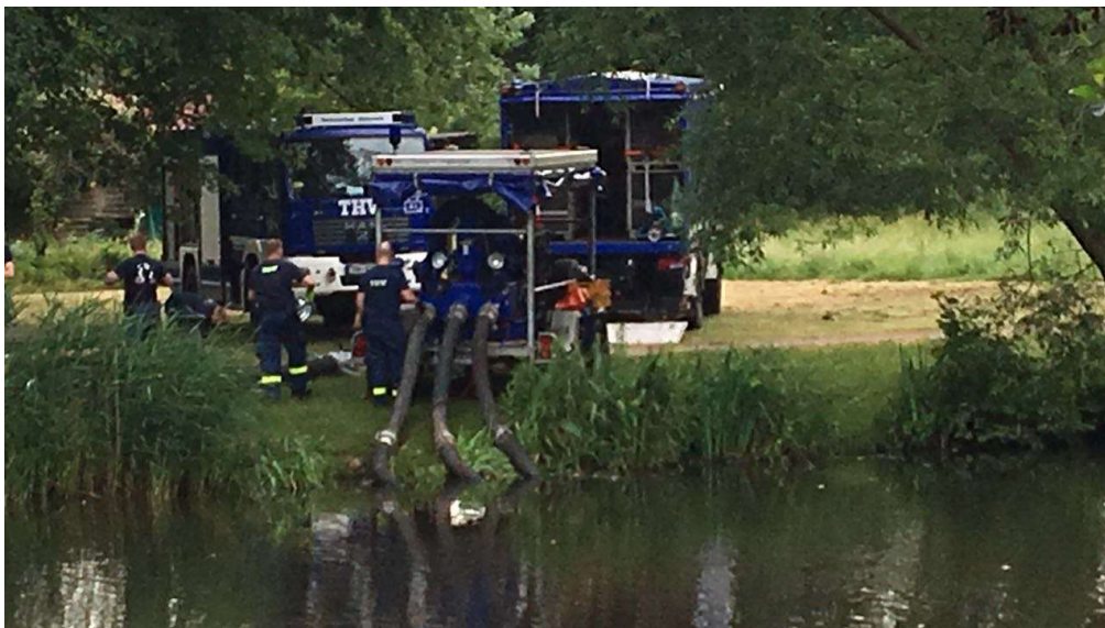
Abbildung 12: Abbau der Großpumpe am Aßmannkanal [aus 132]
