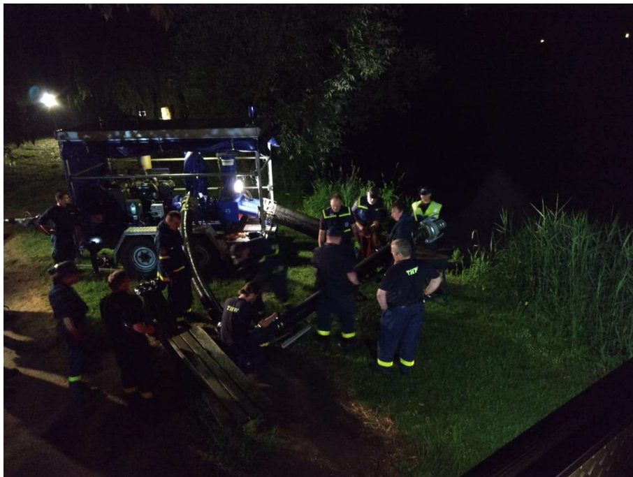
Abbildung 11: Aufbau der Großpumpe zur Gewässerbelüftung Aßmannkanal [aus 132]
