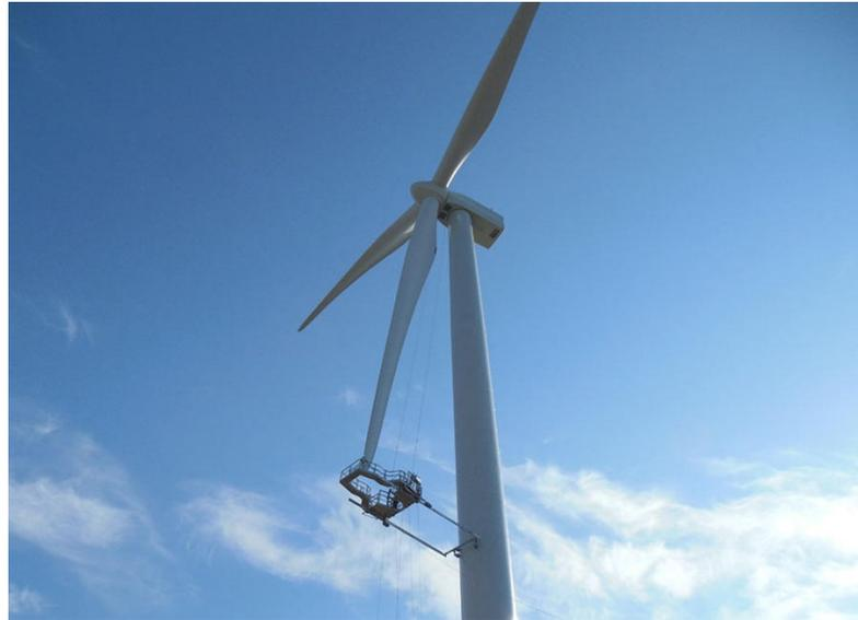
**Abbildung 3.4: Rotorblattbefahranlage für Inspektionen und Reparaturen (Quelle: Gebr. Käufer GmbH)**
