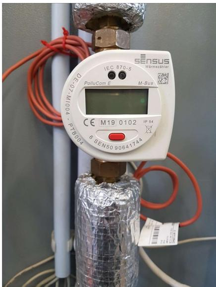
Abbildung 12 Vollklimaanlage Wärmemengenzähler Nacherhitzer
