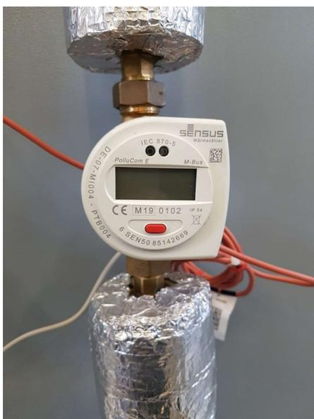
Abbildung 13 Vollklimaanlage Wärmemengenzähler Vorerhitzer
