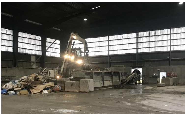
Abbildung 42: Halle, in der die Anlieferungen abgeladen werden und vorsortiert werden [52]
