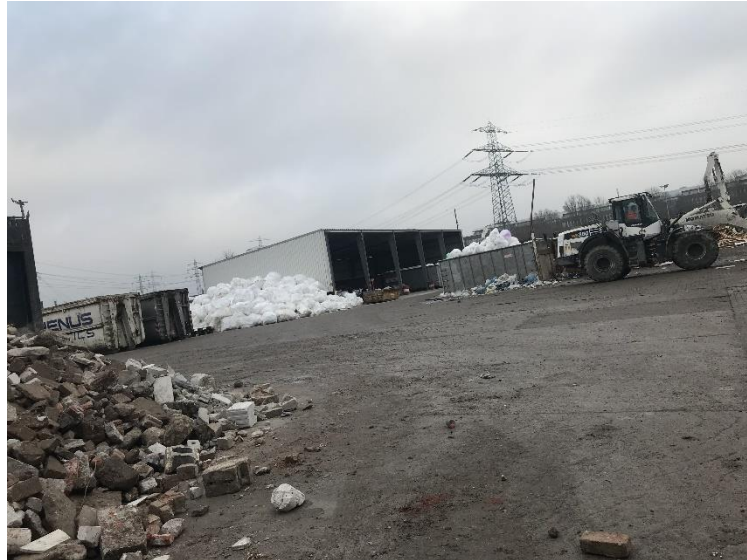
Abbildung 50: Ausblick auf den Anlagenhof [52]
