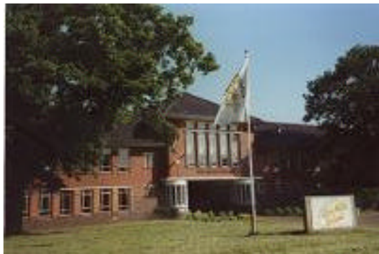
Abb. 2 Außenansicht der GMS in Wezep (Foto: Förster 2001)
