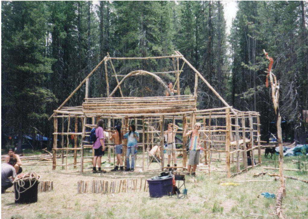
Foto 1: Ein Theater entsteht. Später wurden Solarzellenplatten installiert, um Scheinwerfer während den Vorführungen betreiben zu können
