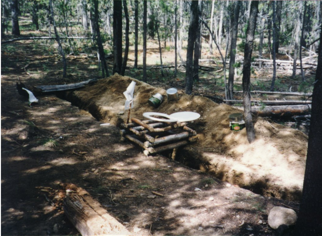
Foto 7: Ein Beispiel für ein „Shitpit“ – die Konstruktion wird verschoben, wenn das Fassungsvermögen des Grubenstücks darunter erreicht ist
